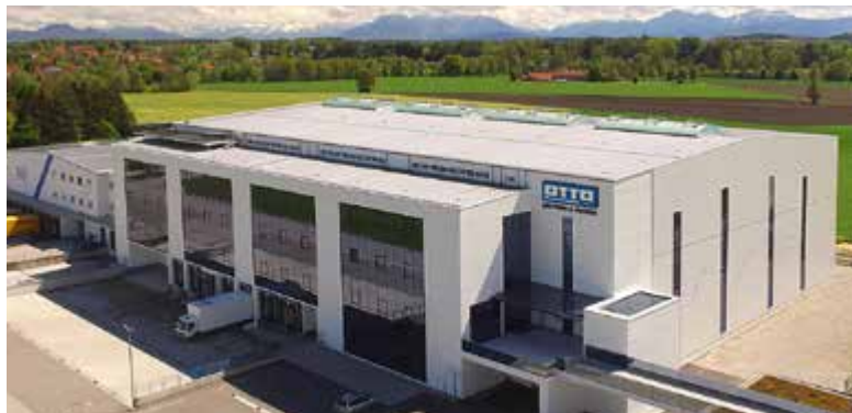
Logistik- und Schulungszentrum Strohhof
