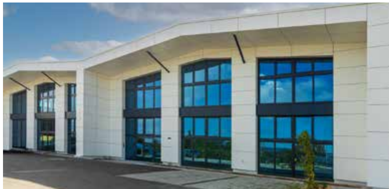
Neubau Produktion und Labor im Schwalbenweg
