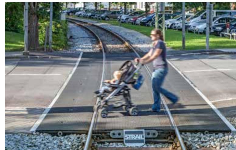
ten Einzelementen montiert werden können, die Elemente müssen ohne zu kippeln stabil miteinander verbunden sein, sie dürfen sich unter Bremsbelastung nicht verschieben, sie müssen Gleisradien ausgleichen können, die Fuge am Schienenkopf muss groß genug sein, um dem Spurkranz des Eisenrades Platz zu lassen, aber so klein als möglich, um dem Reifen des Straßenfahrzeugs nur minimalen Widerstand zu leisten.
