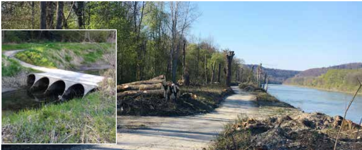
Auf deutscher Seite wurden bereits die Bäume entfernt.
