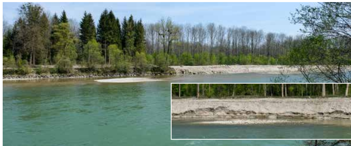
Bereits jetzt ist die Erosion am österreichischen Uferstreifen zu erkennen.
