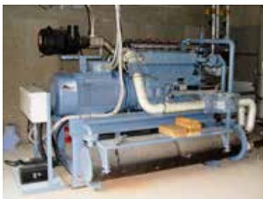
*Blockheizkraftwerk wandelt Biogas in Strom und Wärme um.*
