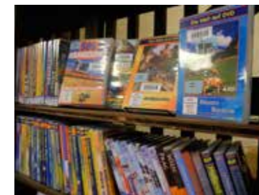
Für die neuen DVDs wurden neue Regale eingebaut
